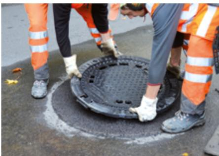
10 - Einsetzen der selbstnivellierenden Abdeckung
