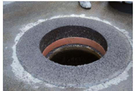
09 - Fertiger Aufbau nach Herausnahme der Einbauhilfe
