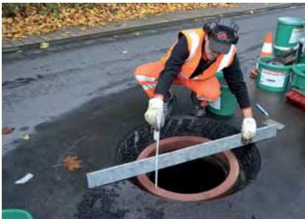
04 - Fertiger konischer Ausbau mit neuem Adapterring
