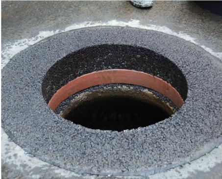
10 Fertiger Aufbau nach Herausnahme der Einbauhilfe
