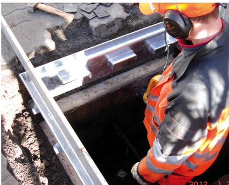
07 Ausrichten der Schachtabdeckung
