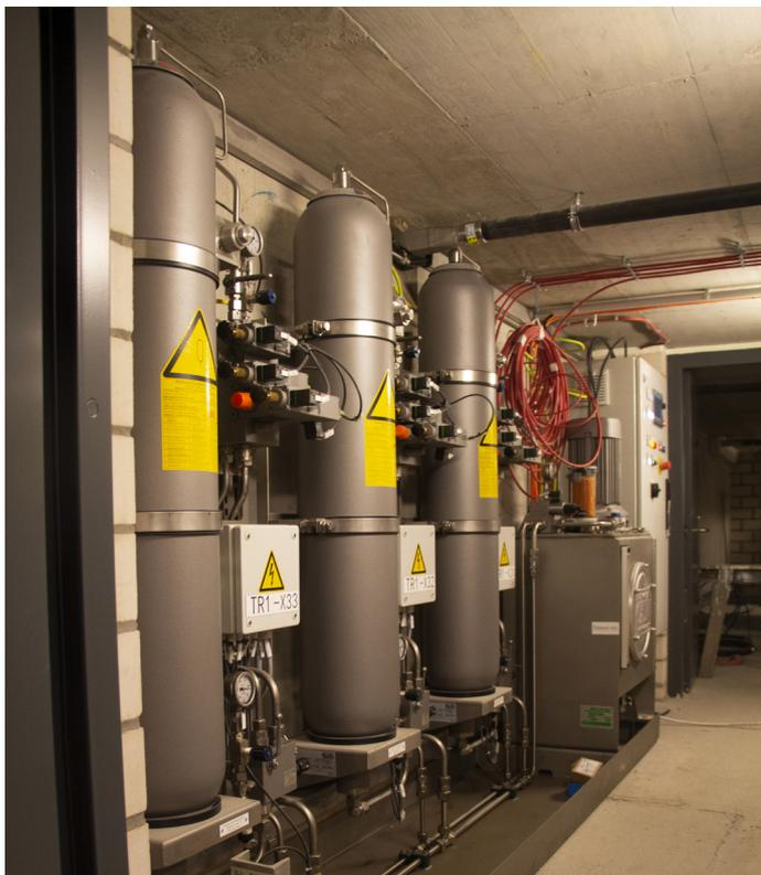
Steuerung mit Aggregat und Blasenspeicher in einem Schaltschrank
