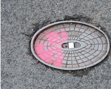
01 Alte beschädigte Hydrantenkappe
