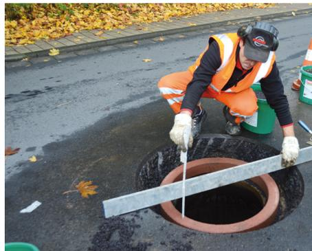
05 Fertiger konischer Ausbau mit neuem Adapterring
