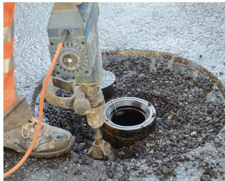
05 Lagenweiser Aufbau und Verdichten des Kaltmaterials
