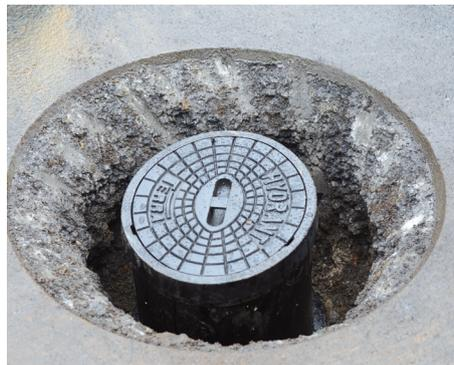
05 Fertiger konischer Ausbau mit neuer Hydrantenkappe
