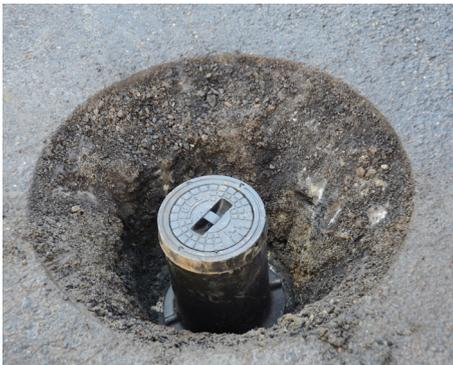
04 Fertiger konischer Ausbau mit neuer Schieberkappe
