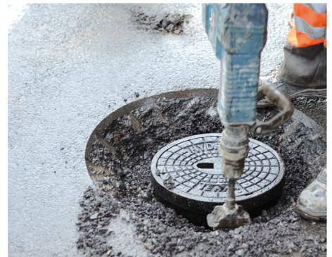
06 Lagenweiser Aufbau und Verdichten des Kaltmaterials
