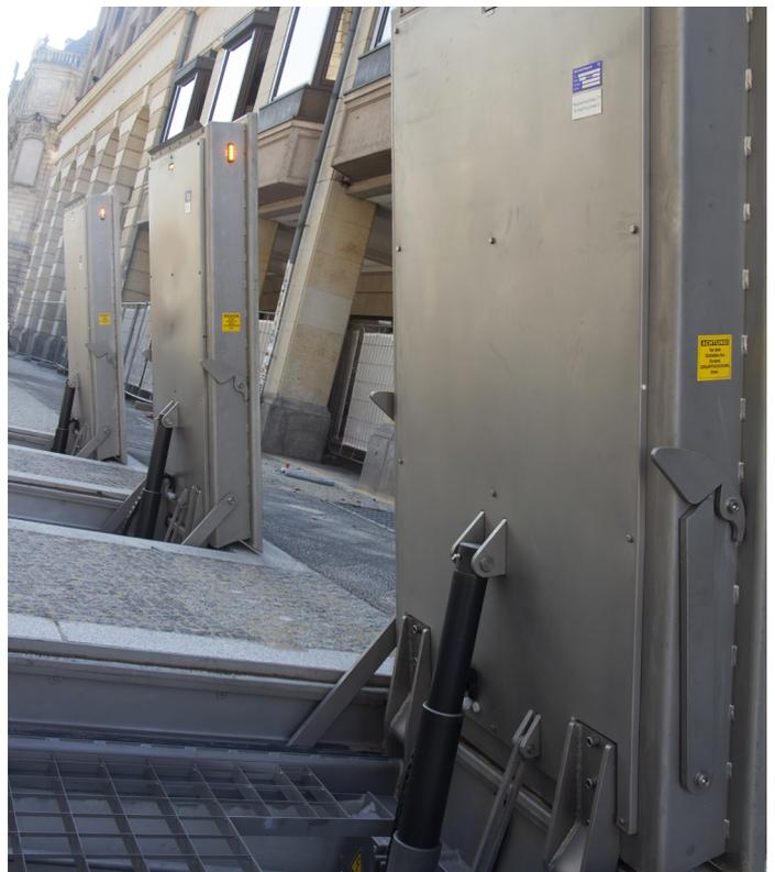
Beispielhafte Darstellung mit zusätzlichem Handhebelventil für die Notöffnung mit Blasenspeicher
