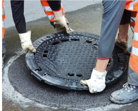
11 Einsetzen der selbstnivellierenden Abdeckung
